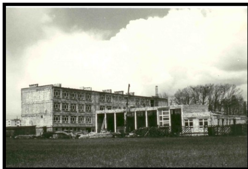
Fot. 1 Szkoła w budowie.
